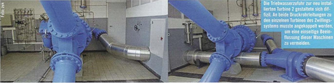
Die Triebwasserzufuhr zur neu installierten Turbine 2 gestaltete sich diffizil. An beide Druckrohrleitungen zu den einzelnen Turbinen des Zwillingssystems musste angekoppelt werden, um eine einseitige Beeinflussung dieser Maschinen zu vermeiden.
