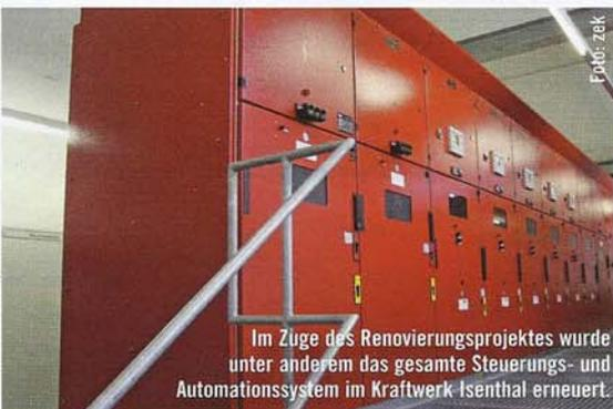
Im Zuge des Renovierungsprojektes wurde unter anderem das gesamte Steuerungs- und Automationssystem im Kraftwerk Isenthal erneuert.
