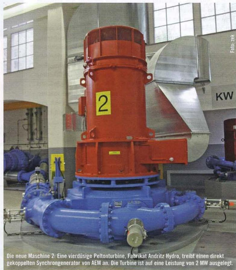
Die neue Maschine 2: Eine vierdüsig Pelton turbine, Fabrikat Andritz Hydro, treibt einen direkt gekoppelten Synchrongenerator von AEM an. Die Turbine ist auf eine Leistung von 2 MW ausgelegt.
