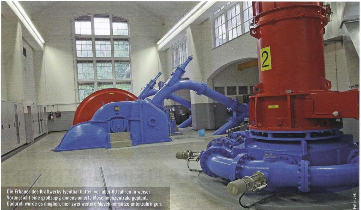
Die Erbauer des Kraftwerks Isenthal hatten vor über 60 Jahren in weiser Voraussicht eine großzügig dimensionierte Maschinenzentrale geplant. Dadurch wurde es möglich, hier zwei weitere Maschinensätze unterzubringen.
