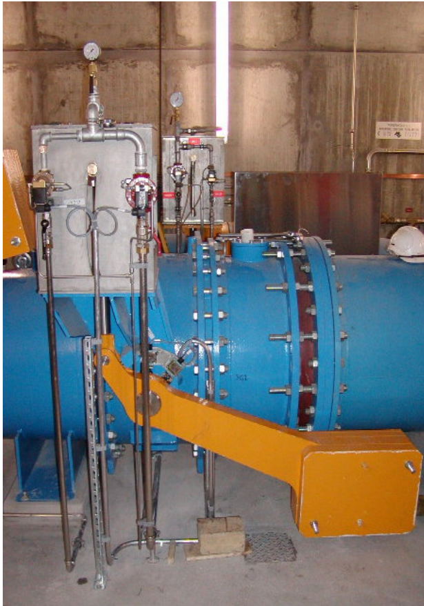
JMC-Aquaforce Standard Antrieb als Turbinenabsperriklappe Drehklappe DN 900 – PN10
